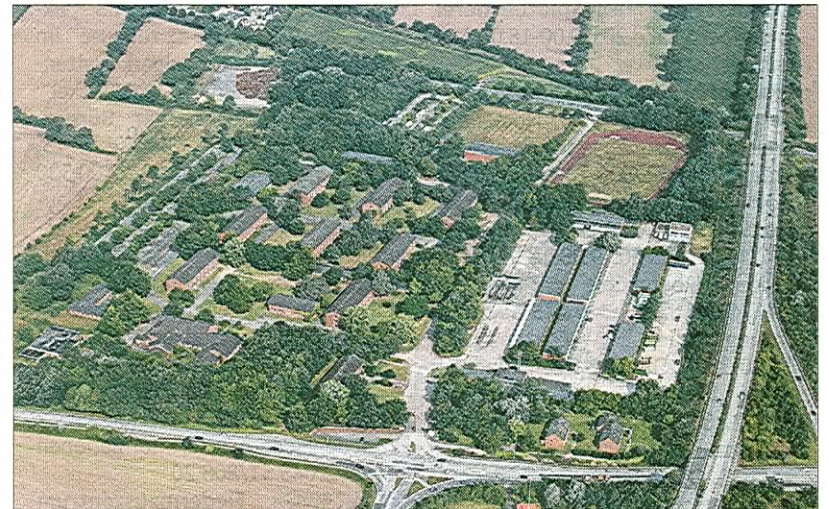
In den „Stuben“ eines früheren Kompaniegebäudes im Levo-Park soll das neue Gründerzentrum mit 37 Büroeinheiten untergebracht werden.
